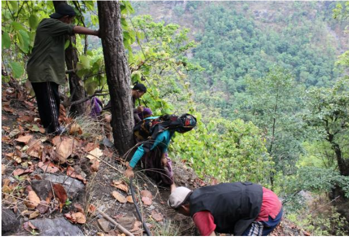
Arbeiter graben die Wasserleitung in die Erde.
