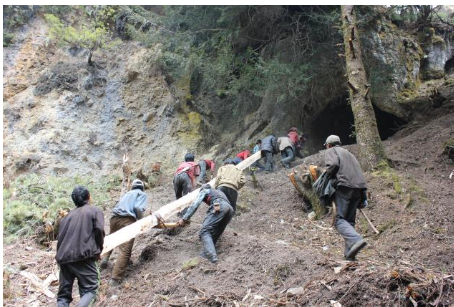
Die Dachbalken wurden direkt im Wald bearbeitet und dann zur Schule getragen.
