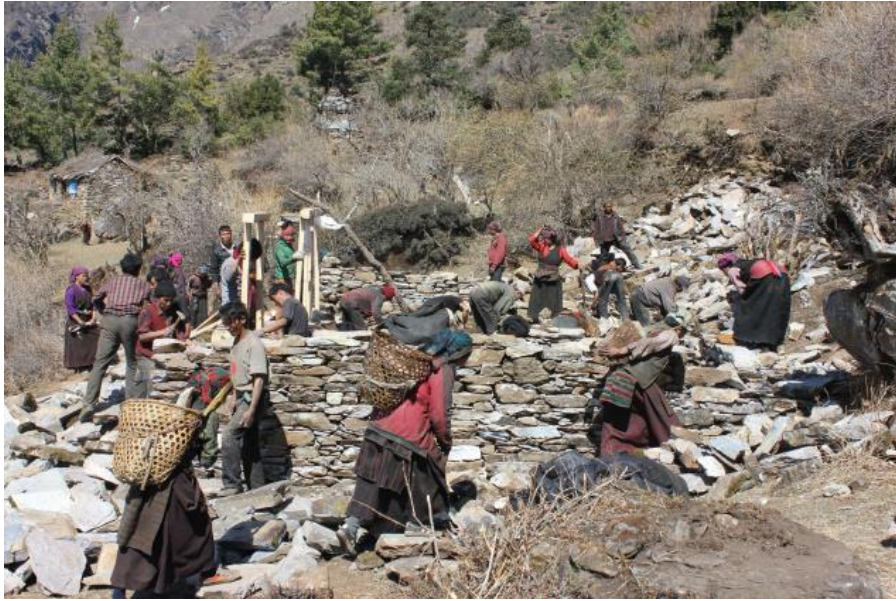
Bau der Schule in Yarcho. Steine wurden angeschleppt, die Mauern gemauert, die Türen gezimmert und schon während des Baus eingesetzt.
